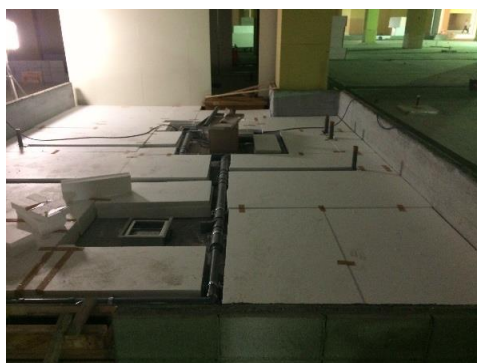
「RCフォーム」 施工中
