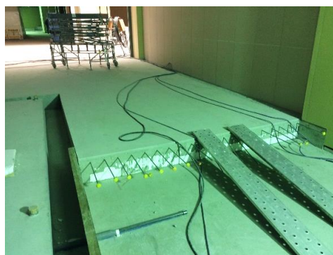
「RCフォーム」+コンクリート打設後
